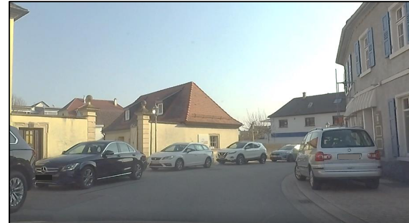
Eingeschränkte Sichtverhältnisse in Kurvenbereichen (Bruchsaler Straße)
